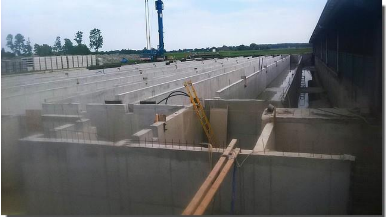
Na het storten van de vloer werden de putmuren gestort.
