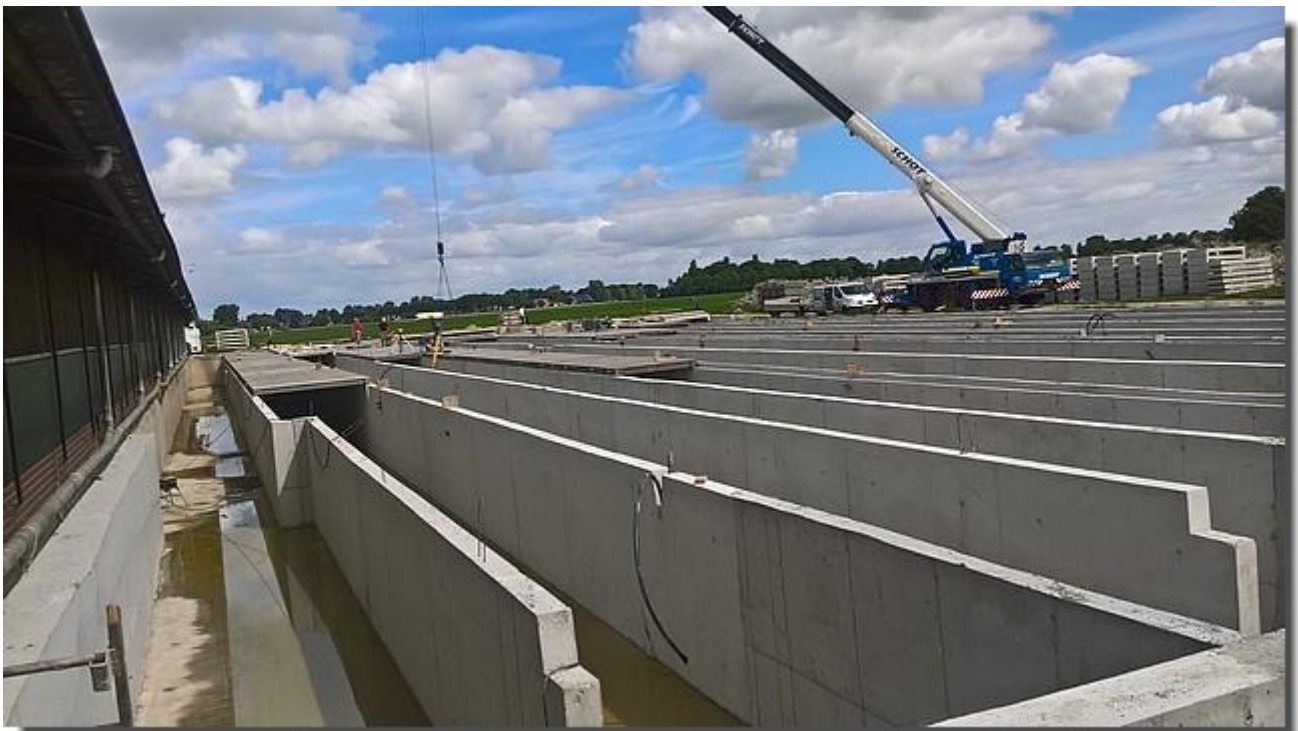
Dan de roosters en boxdekken erop.
