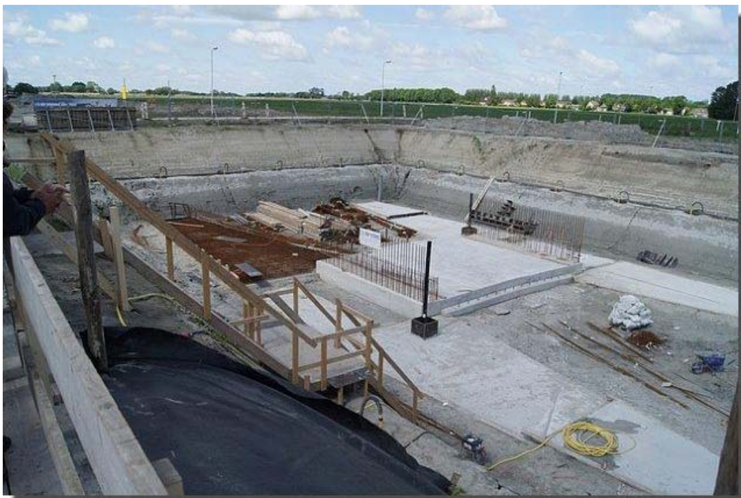
In de midden van bovenstaande foto is de doorgang van de tunnel zichtbaar, al lijkt dit smal de doorgang is 8 meter breed.
