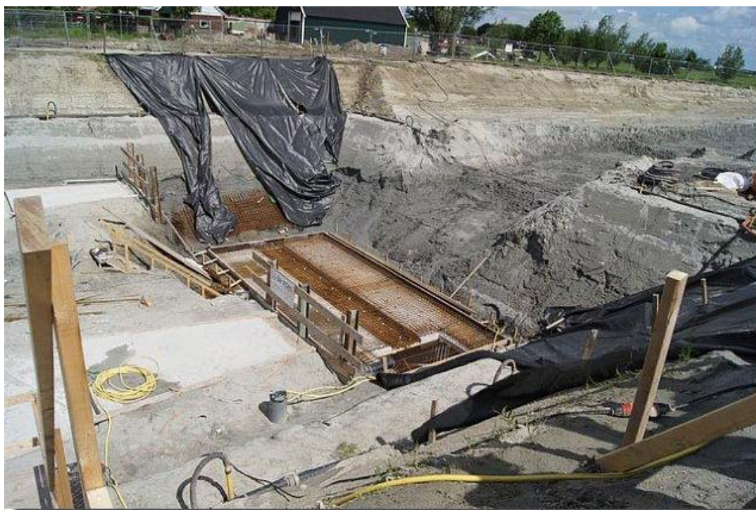
Hier de wateropvang bak in aanbouw. Dit is de bufferbak voor het regenwater wat straks in de tunnel komt. Vanuit deze bak word het in een nog aan te leggen vijver gepompt waarna het weer op het oppervlakte water geloosd word.
