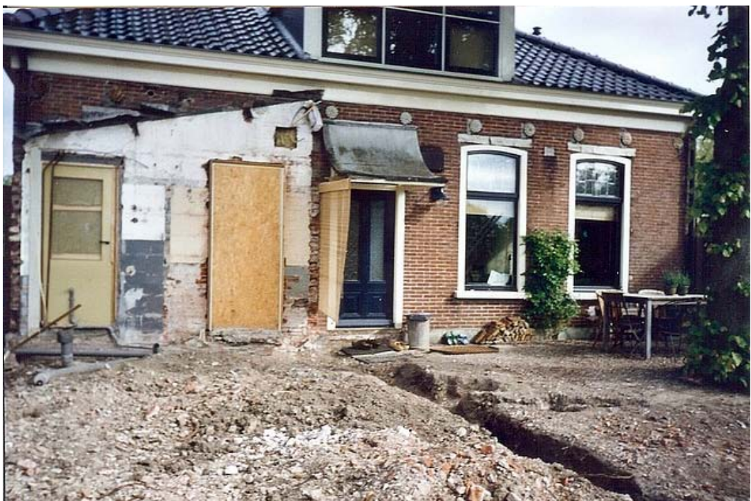
Op deze foto is de aanbouw gesloopt en heeft plaats gemaakt voor een nieuwe aanbouw van de huidige bewoners.
