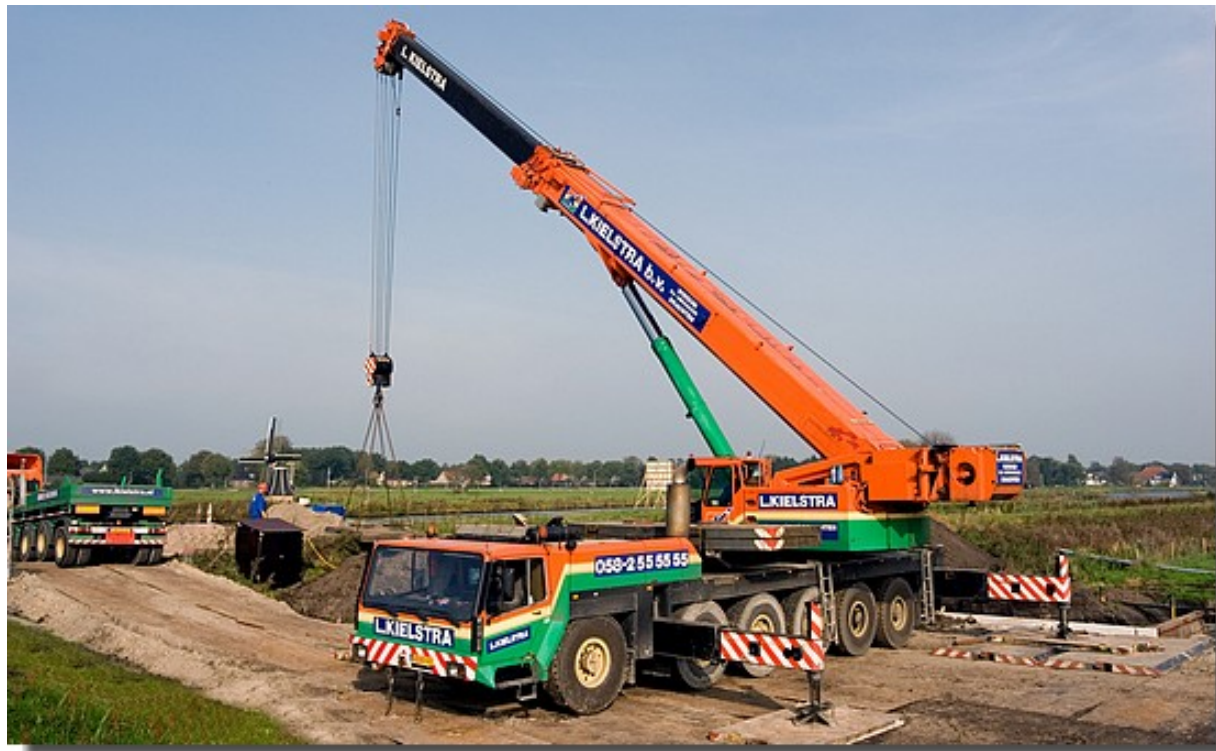
Plaatsen betonnen prefab kelders voor gemalen. Gewicht ca 50 ton. Kraan LTM 1160, 160 tonner met ballastwagen. Locatie Mildam.
