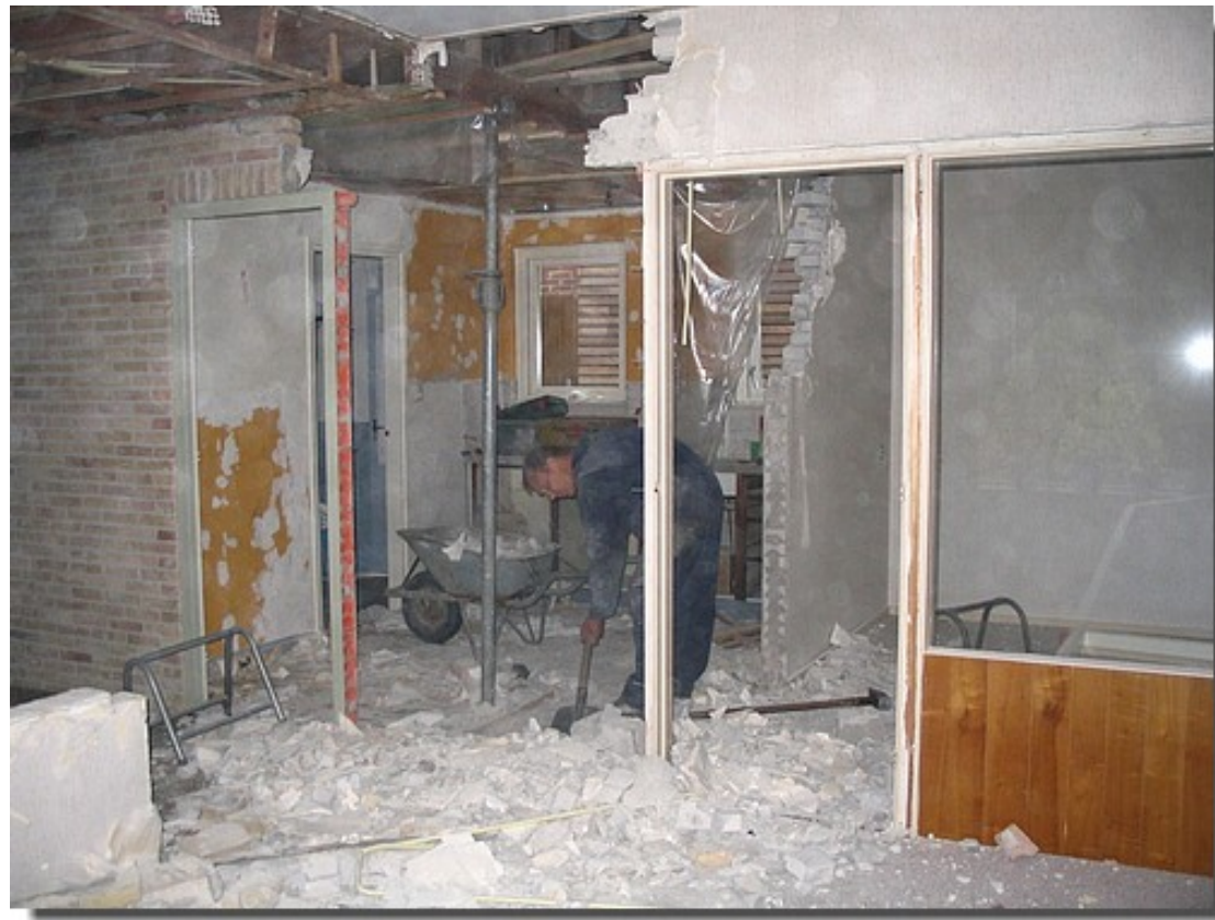
Het puin wordt geruimd.
